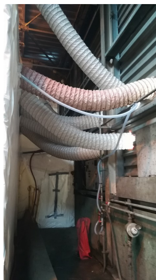
Vue de l'arrière de la structure de confinement avec en fond d'image le sas d'accès du personnel et en premier plan les conduites d'aération
