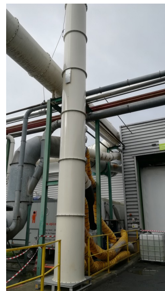
Vue de l'arrière de la structure de confinement avec en fond d'image le sas d'accès du personnel et en premier plan les conduites d'aération
