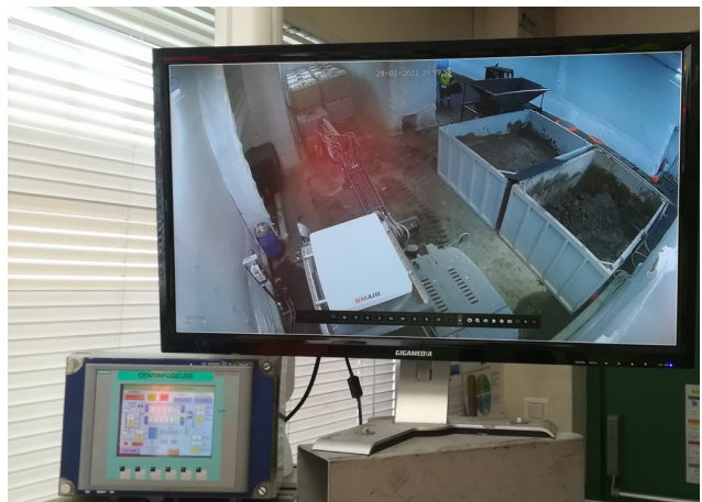
Contrôle déporté par caméra de la zone 1 de traitement
